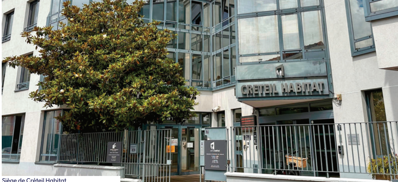
Siège de Créteil Habitat
