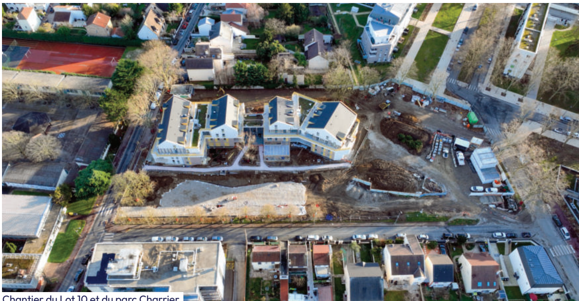
Chantier du Lot 10 et du parc Charrier
