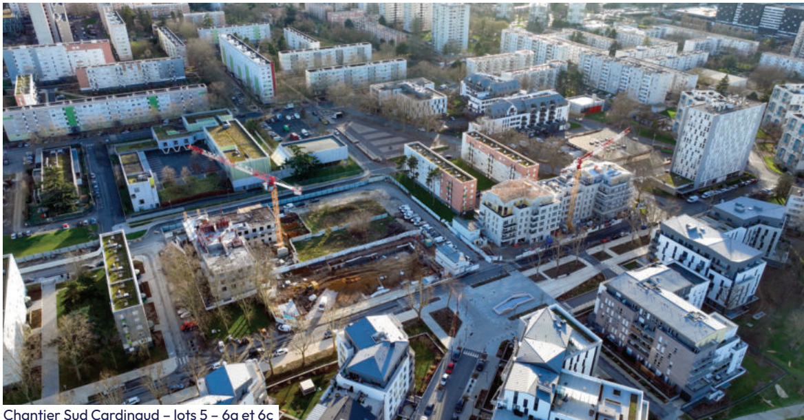
Chantier Sud Cardinaud – lots 5 – 6a et 6c
