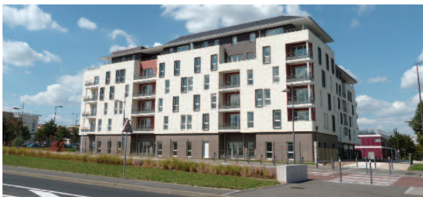
2015, Résidence Christophe Colomb : Créteil Habitat OPH livre 63 logements locatifs sociaux dans le quartier Pointe du Lac.
