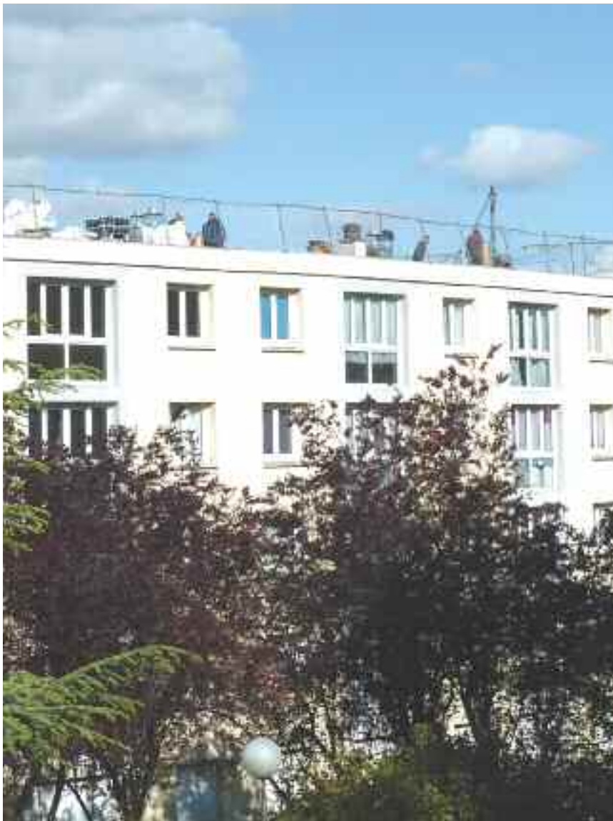
Travaux d'étanchéité toiture
